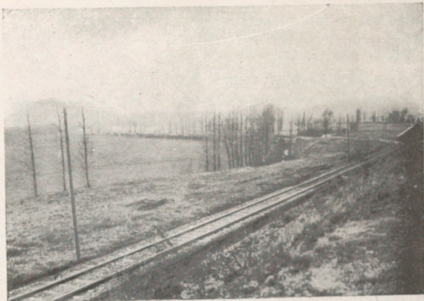
La voie de raccordement qui relie l'Usine à la gare de Guise.
