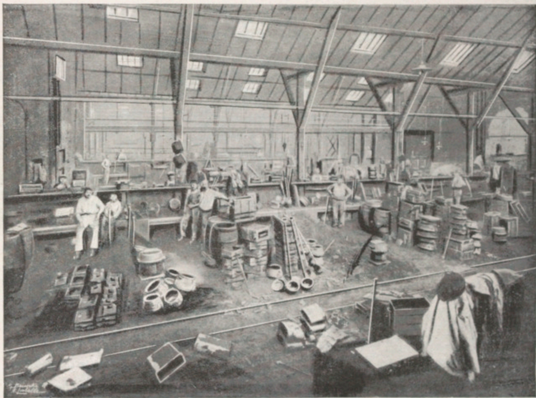
Un coin de l'atelier de Fonderie à Guise : Moulage à la main
