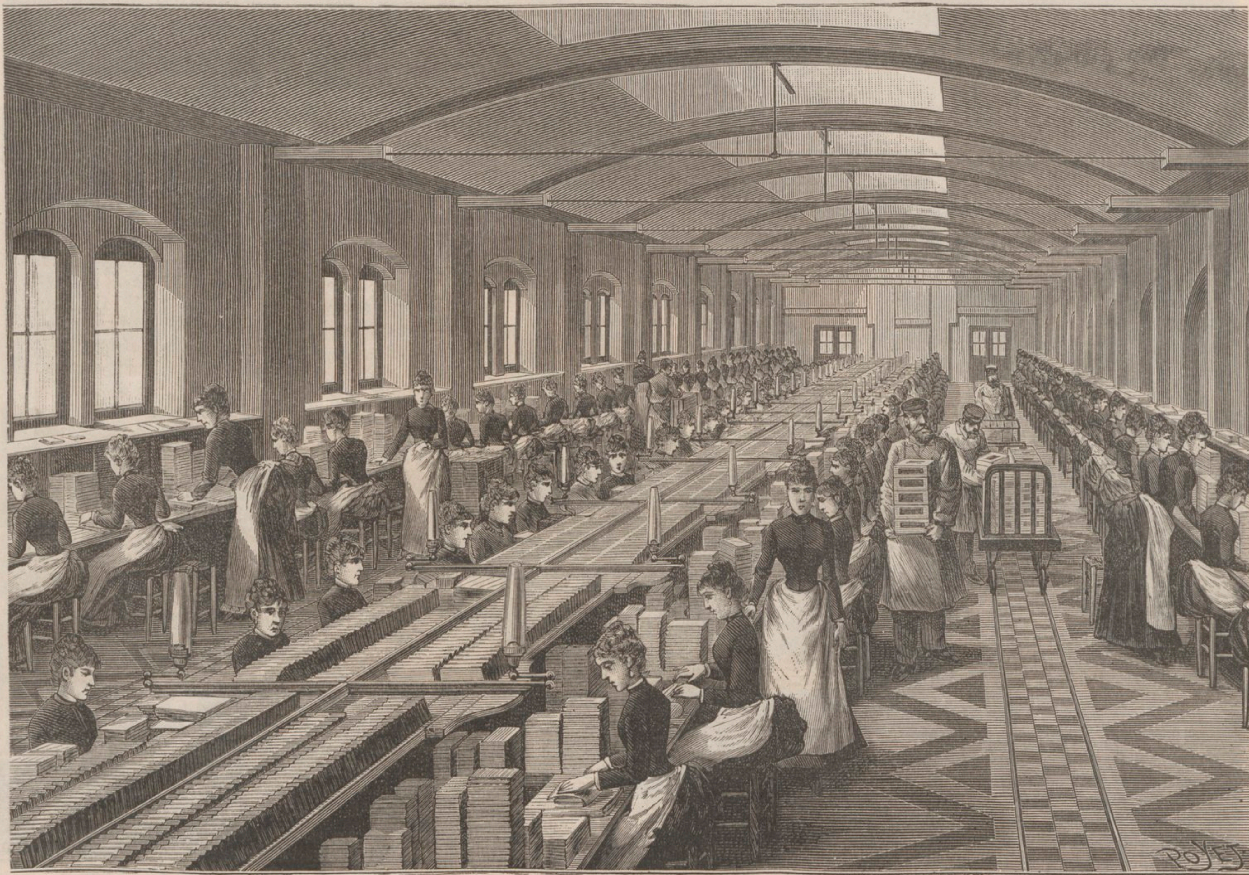
FIG. 8. — USINE DE NOISIEL. — Vue d'un des ateliers de pliage et d'emballage des tablettes.
